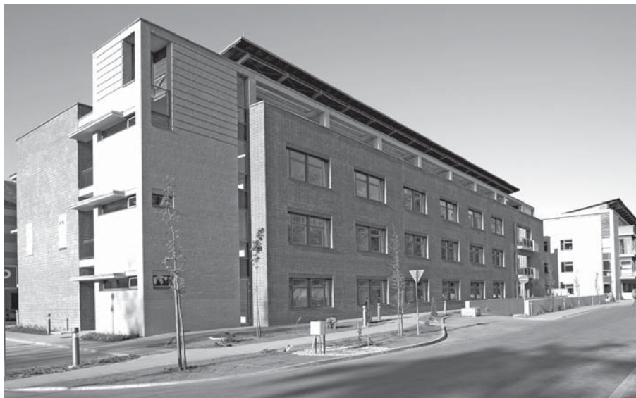
A magasföldszinten és az első emeleten az 1-4 ágyas kórtermek, a mélyföldszinten az adminisztratív részleg, a tetőtérben épületgépészeti berendezések kaptak helyet.
