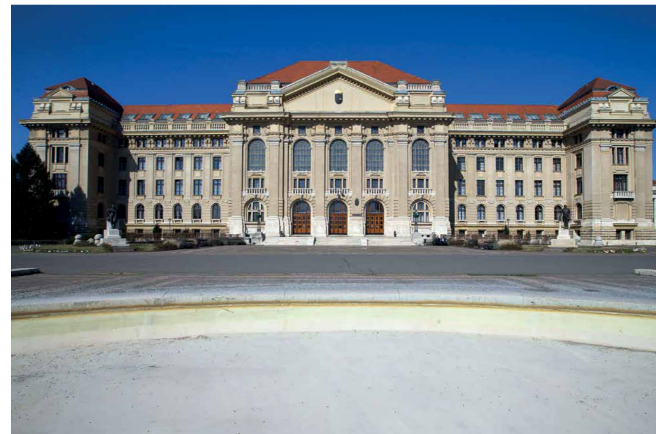
A Főépület 2020-ban
